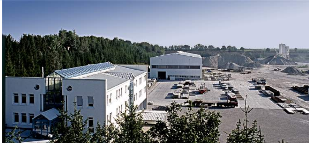
Verwaltungsgebäude mit Technischen Büros und Produktionshalle mit Lagerplatz
